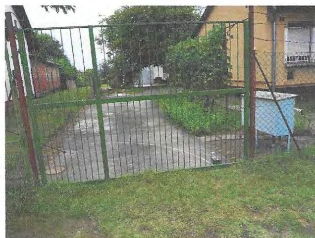
04. szomszéd ingatlan kerítése
